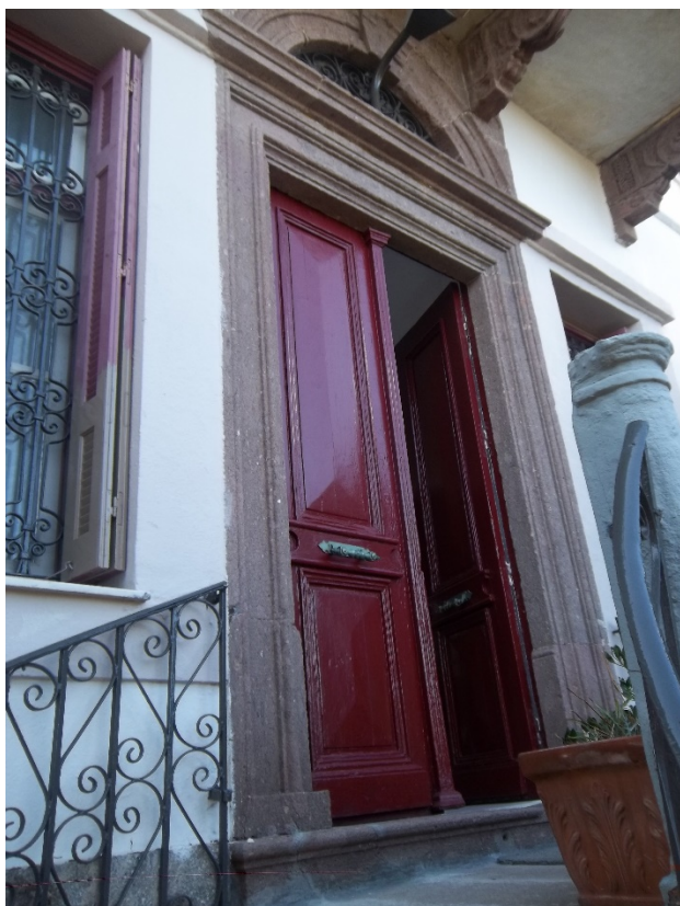
ΦΩΤΟ.11. ΘΥΡΑ 1ου ΟΡΟΦΟΥ ΕΞΩΤΕΡΙΚΑ
