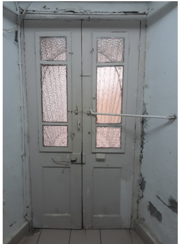
ΦΩΤΟ.10. ΘΥΡΑ ΙΣΟΓΕΙΟΥ ΕΣΩΤΕΡΙΚΑ
