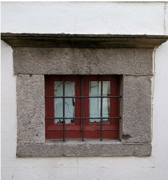
ΦΩΤΟ.5. ΠΑΡΑΘΥΡΟ ΙΣΟΓΕΙΟΥ ΕΞΩΤΕΡΙΚΑ
