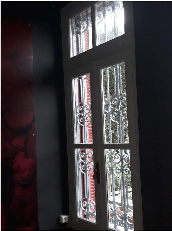
ΦΩΤΟ.7. ΠΑΡΑΘΥΡΟ 1ου ΟΡΟΦΟΥ ΕΞΩΤΕΡΙΚΑ
