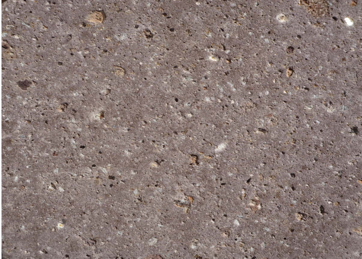
Εικόνα 1 Όψη κατεργασμένης επιφάνειας λίθου από πέτρωμα ιγνιμβρίτη
