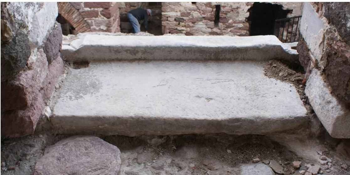
Εικ. Β11-Β13 Θύρα αίθουσας προσευχής. Διατηρείται το κατώφλι από γκριζωπό (λευκόφαιο) μάρμαρο με τις λοξότμητες απομήσεις για την προσαρμογή των παραστάδων του θυρώματος που φέρουν εντορμίες ορθογωνικής διατομής για τη σύνδεση των μελών.
