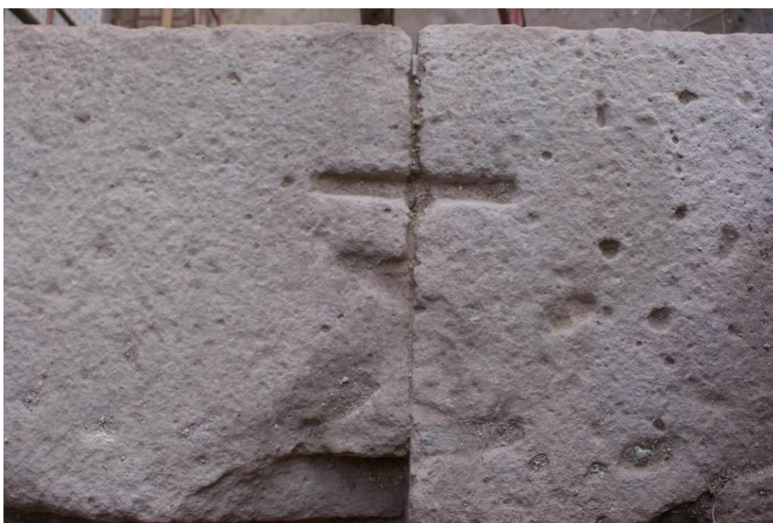
Εικ. Α11 Τμήμα του γείσου επίστεψης της στοάς στο ισόγειο (άνω όψη). Τα επιμέρους μέλη είναι συνδεδεμένα με διπλούς πειόσχημους σιδηρούς συνδέσμους των οποίων διατηρούνται αποσπασματικά υπολείμματα
