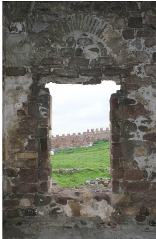
Εικ. Β14-Β15 Παράθυρο αίθουσας προσευχής. Διακρίνονται οι εσοχές στην εσωτερική και εξωτερική παρειά της τοιχοποιίας για την προσαρμογή του μαρμάρινου πλαισίου του ανοίγματος. Τα πλαίσια των παραθύρων στο χώρο αυτό δεν διατηρούνται.
