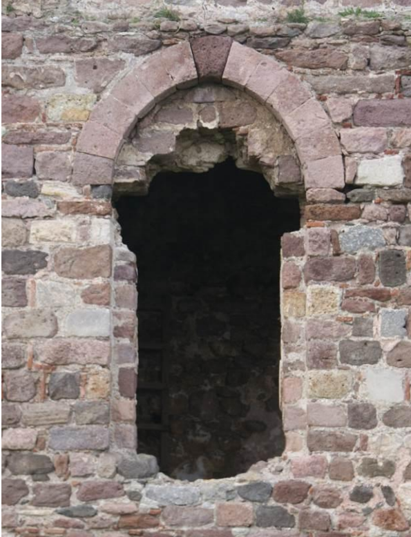
Εικ. Β14-Β15 Παράθυρο αίθουσας προσευχής. Διακρίνονται οι εσοχές στην εσωτερική και εξωτερική παρειά της τοιχοποιίας για την προσαρμογή του μαρμάρινου πλαισίου του ανοίγματος. Τα πλαίσια των παραθύρων στο χώρο αυτό δεν διατηρούνται.
