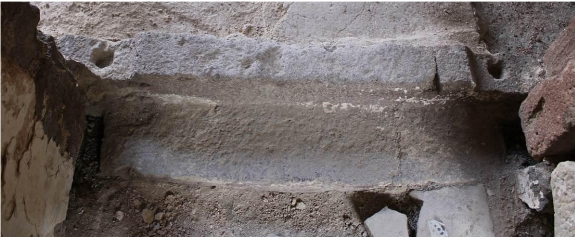
Εικ. Α19-Α21 Κατώφλια λαξευτών πλαισίων θύρας από ιγνιμβρίτη στον όροφο που διατηρούνται κατά χώραν. Διακρίνονται εσοχές κυλινδρικής διατομής (εντορμίες) για την προσαρμογή των παραστάδων.
