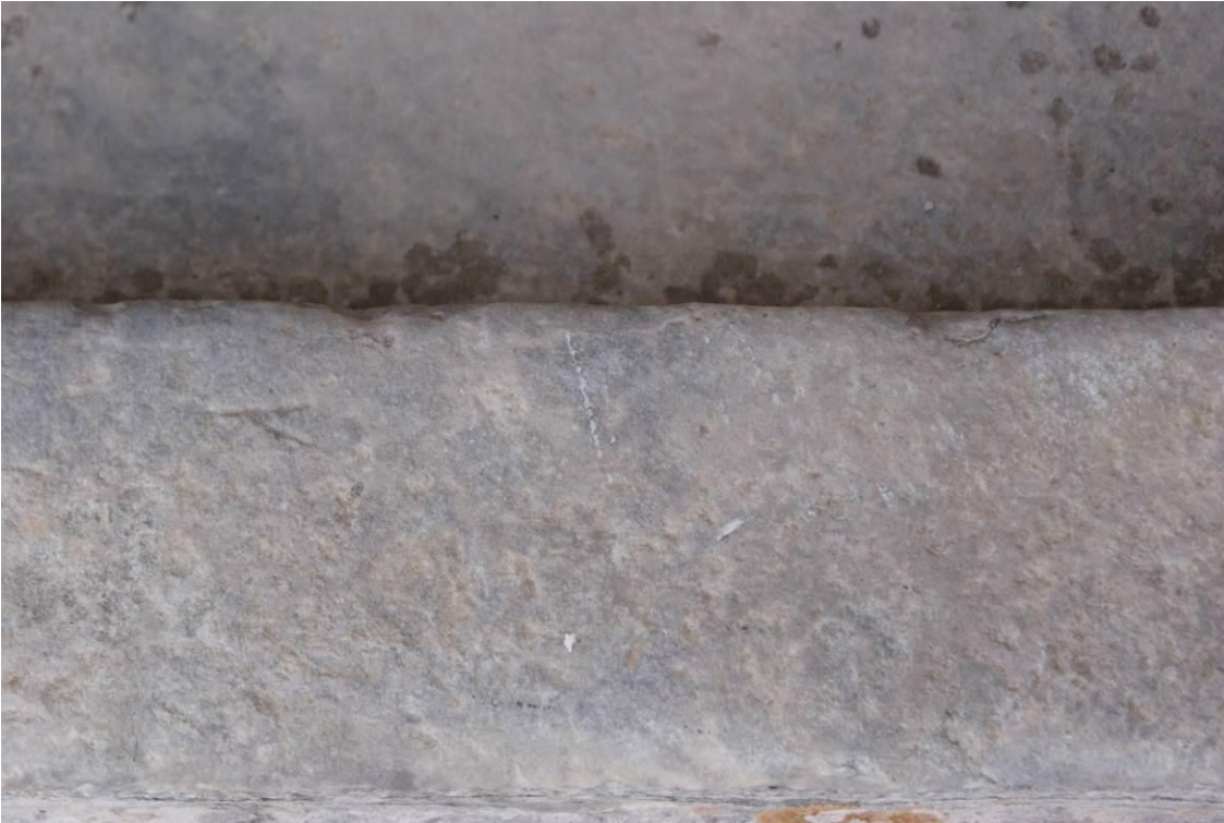
Εικ. Β5 Το μαρμάρινο κατώφλι της εισόδου στην αίθουσα προσευχής. Λεπτομέρεια τελικής επιφάνειας.
