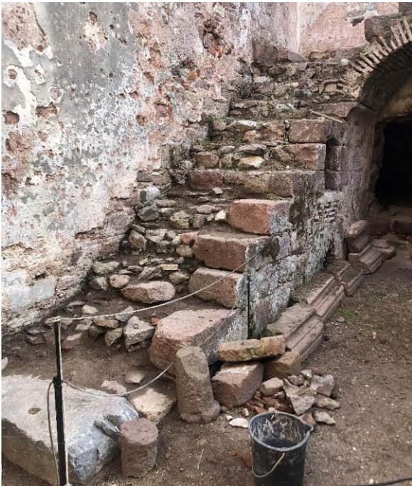
Εικ. Α12-Α13 Υφιστάμενη κατάσταση κλίμακας ανόδου και πλατύσκαλου ορόφου. Διακρίνονται τα ίχνη των βαθμίδων προς ανακατασκευή πάνω στο επίχρισμα του τοίχου. Τμήμα του δαπέδου και του γείσου του πλατύσκαλου έχουν αποστασεί.
