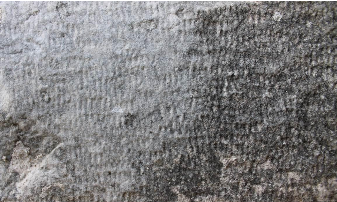
Εικ. Β4 Όψη κατεργασμένης επιφάνειας κατωφλιού από γκριζωπό μάρμαρο στη θύρα της αίθουσας προσευχής (εξωτερική όψη πλαισίου).
