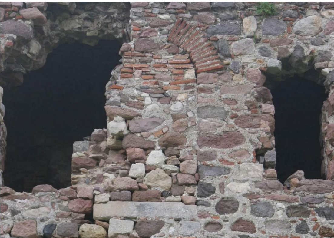
Εικ. Β16 Παράθυρο στη βορειοδυτική όψη (Π212) που έχει πληρωθεί με αργολιθοδομή. Η ποδιά του μαρμάρινου πλαισίου του ανοίγματος διατηρείται στη θέση της.
